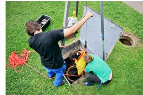
» Reinigung des Schwallwasserbehälters mit anschließender Rettungsübung
