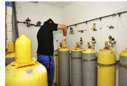
» Chlorgasflaschen-Wechsel bei Bedarf
