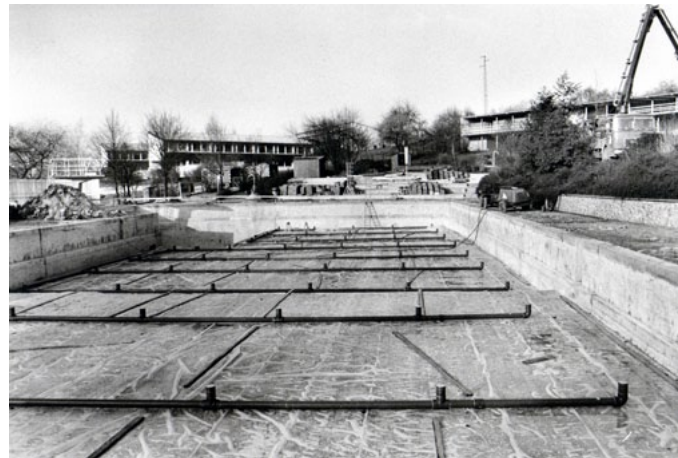
» Umbau des Schwimmerbeckens (1978)
