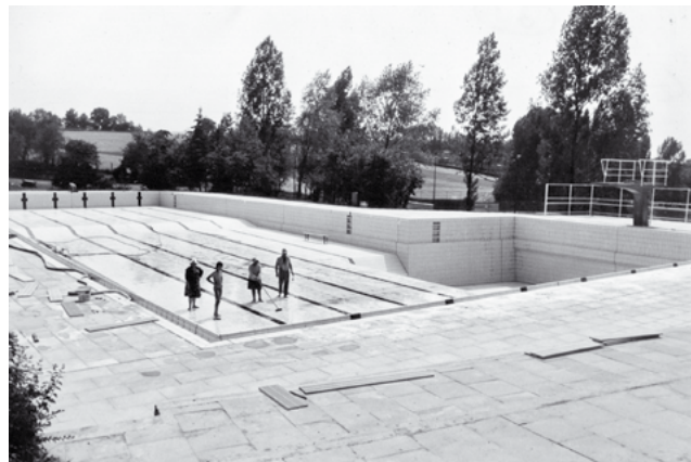
» Reinigungsarbeiten nach der Sanierung
