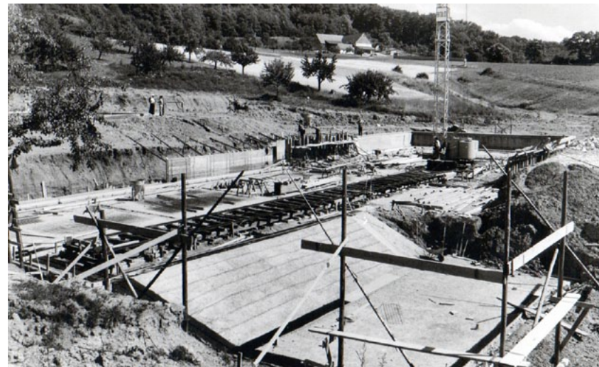
» Bau des Schwimmerbeckens, hier während der Schalung (1958)
