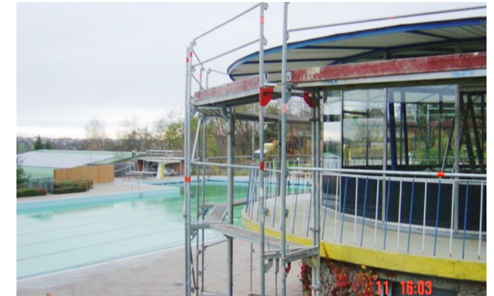
»Renovierung des Schwimmmeisterraumes (2008)
