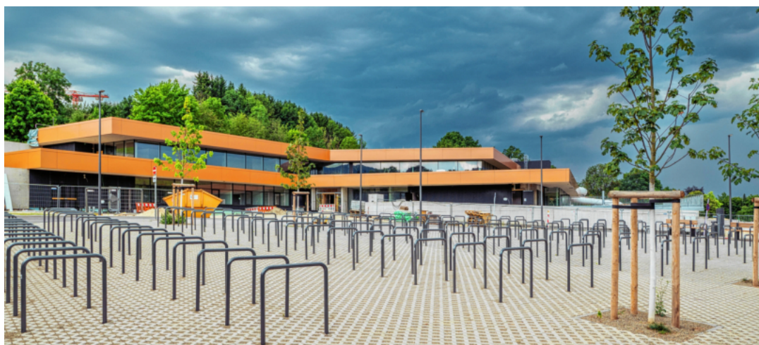
326 Fahrradabstellplätze stehen am Hirschbachbad bereit.
