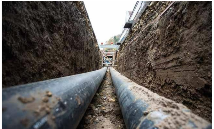
Infrastruktur unter der Erde: Rohrgaben mit Fernwärmeleitung.
