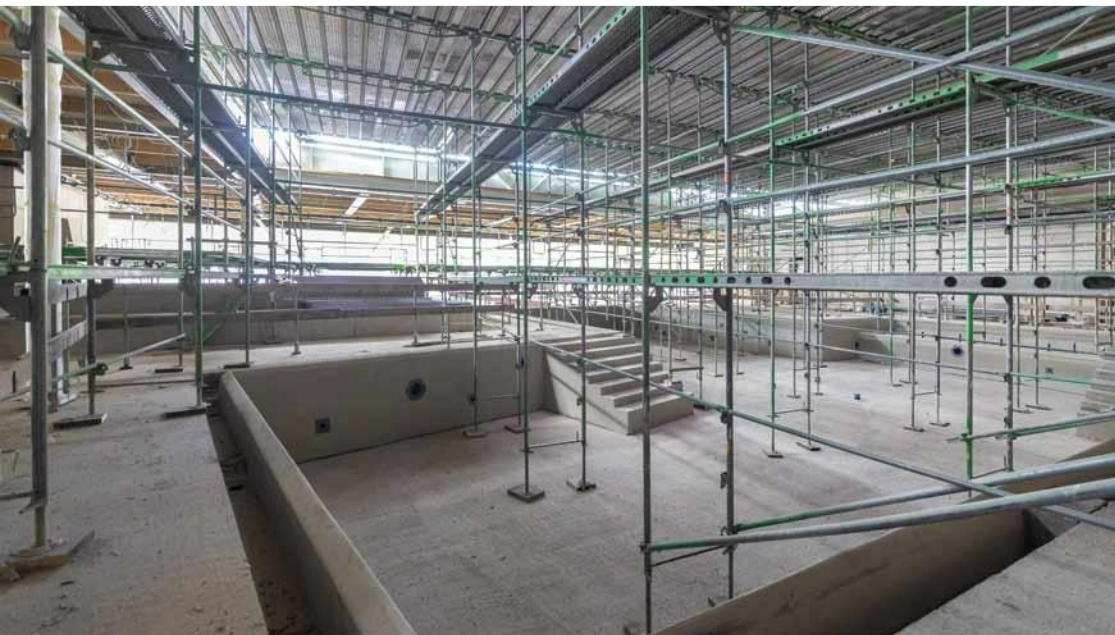
Die Becken im Innenbereich sind bereits ausmodelliert.
