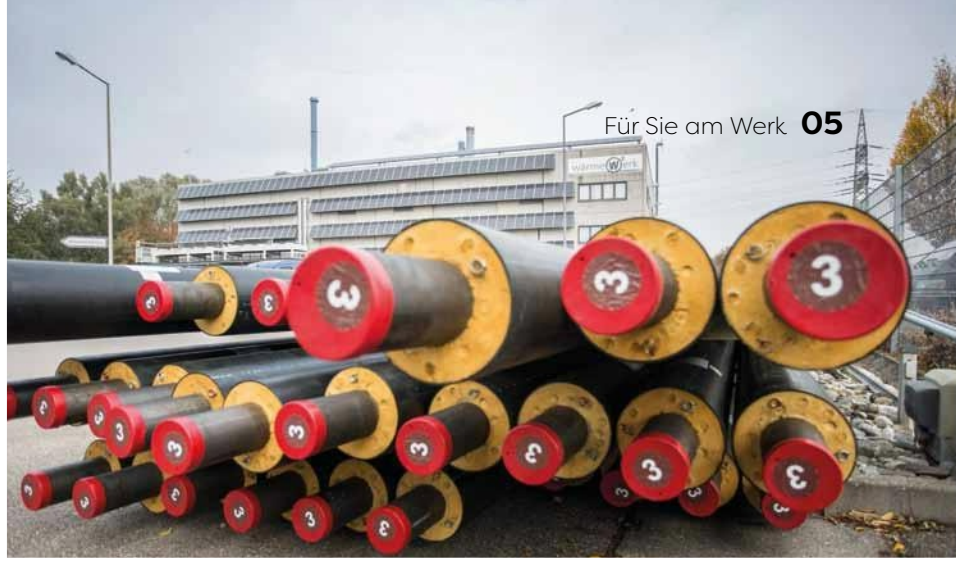
Fernwärmerohrleitungen vor dem Wärmewerk 2.
