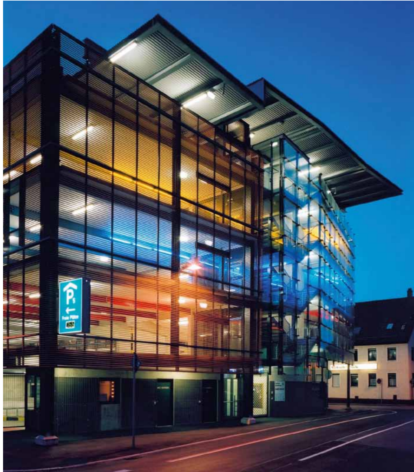
Das Parkhaus in der Spitalstraße
