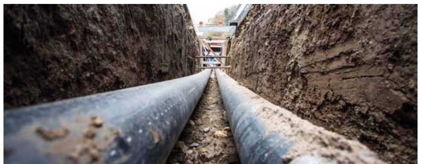
In der Stuttgarter Straße wird das Fernwärmenetz erweitert.
